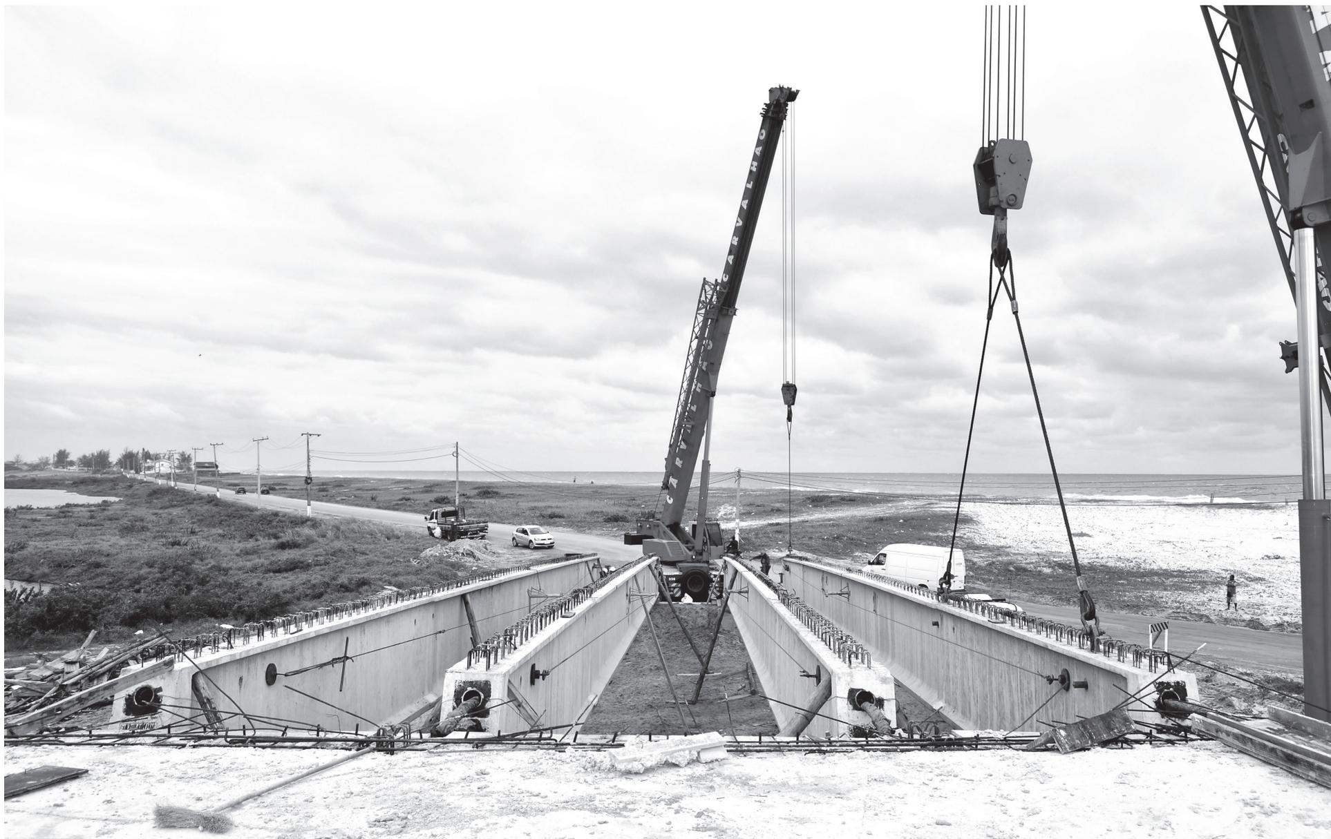
**A**s últimas vigas que compõem a estrutura da ponte da Barra de Maricá foram colocadas sobre os pilares nesta quinta-feira (15/8), iniciando o estágio final da construção. O trabalho começou na véspera com a colocação das grandes peças sobre os caminhões que as transportaram até o local da instalação, mas foi suspenso por causa do mau tempo. A equipe finalizou a operação à tarde e teve o auxílio de dois guindastes.
