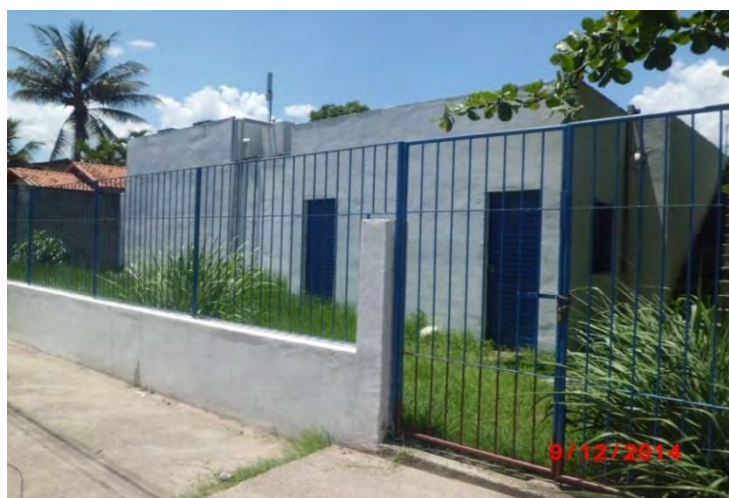
Figura 31: ETE do bairro da Pedreira Fonte: Conen
