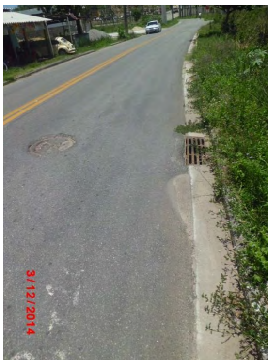
Figura 38: Boca de lobo, sarjeta e poço de visita. Fonte: Conen
