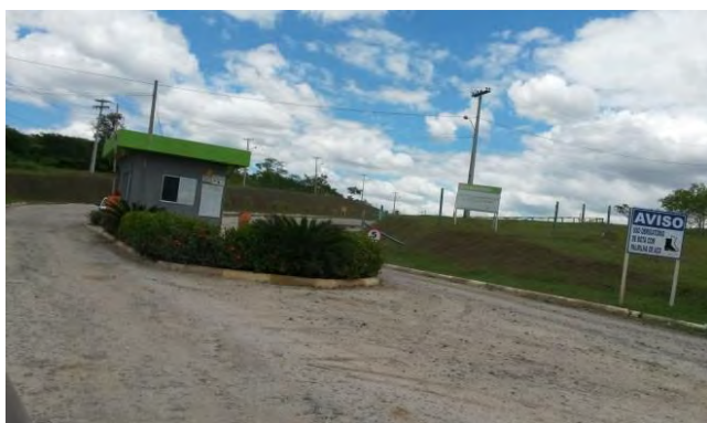
Figura 64: Entrada do CGR Fonte: Conen
