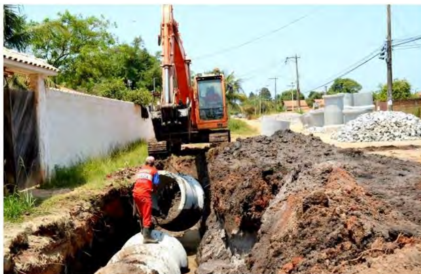
Figura 36: Instalação de manilhas ao longo da Rua dos Narcisos Fonte: Prefeitura Municipal de Maricá, 2014.
