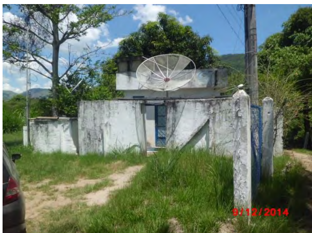
Figura 4: Entrada da captação Fonte: Conen
