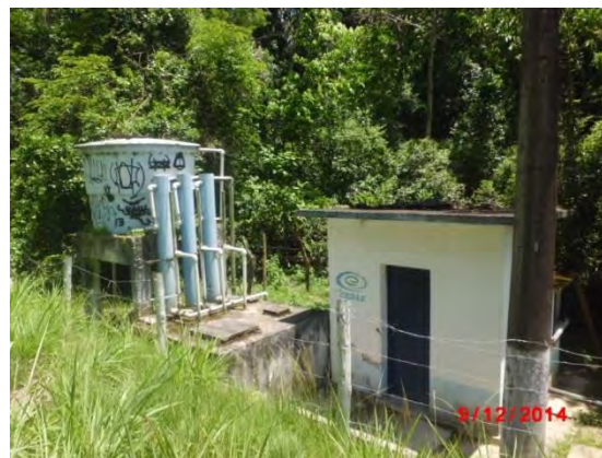
Figura 13: Poço Manoel Ribeiro Fonte: Conen
