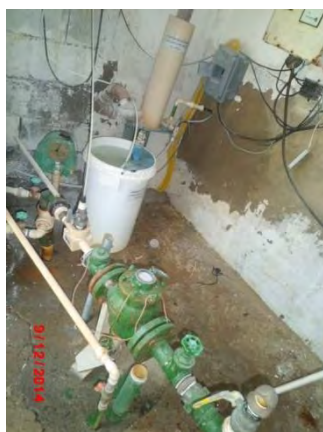
Figura 20: Tratamento no Poço do Marquês Fonte: Conen
