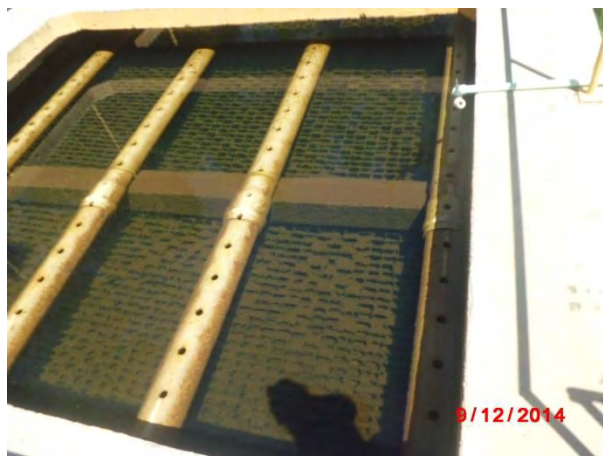
Figura 19: Decantador Fonte: Conen
