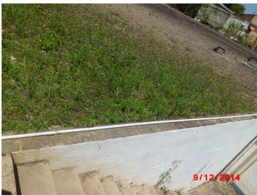
Figura 23: Reservatório de água tratada Fonte: Conen
