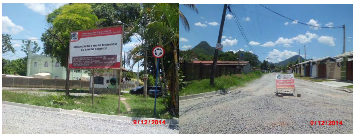
Figura 37: Obras de urbanização e microdrenagem do Bairro de Condado. Fonte: Conen
