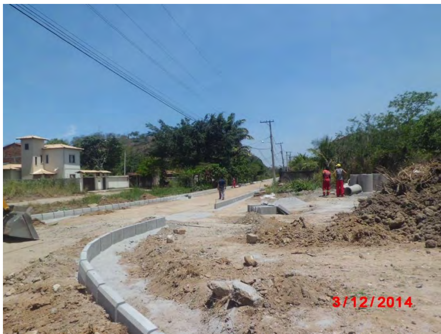
Figura 50: Obras de Pavimentação – Distrito de Itaipuaçu Fonte: Conen
