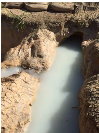
Figura 28: Perfuração do Duto. Fonte: Prefeitura de Maricá
