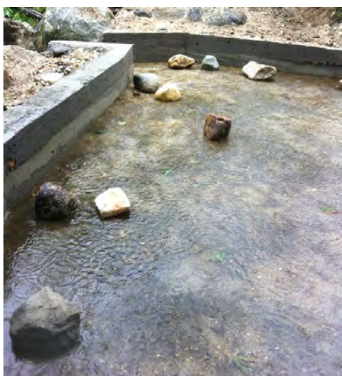
Figura 8: Impermeabilização e desvio dos cursos de água
